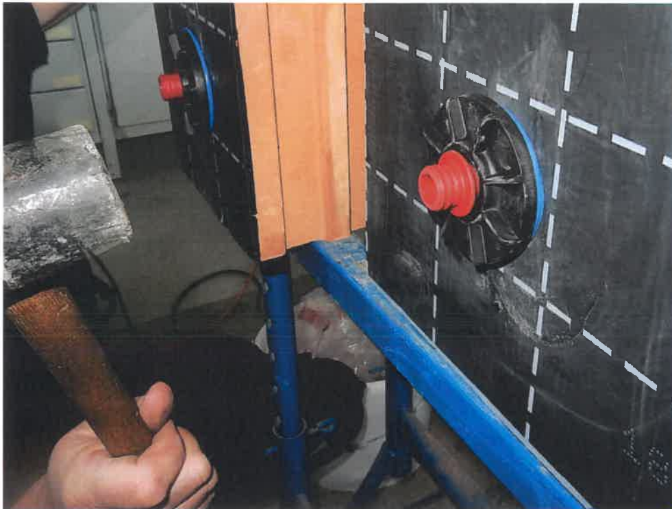
Bild 9 Einschlagen der Spannhülse
