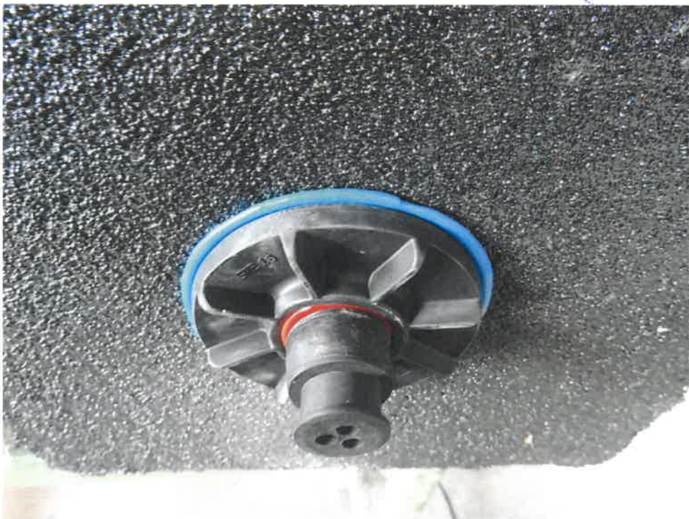
Bild 10 fertig eingebaute SPE-Einführung
