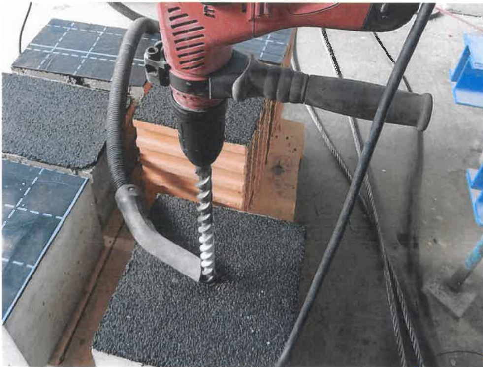
Bild 5 Herstellen der Bohrungen
