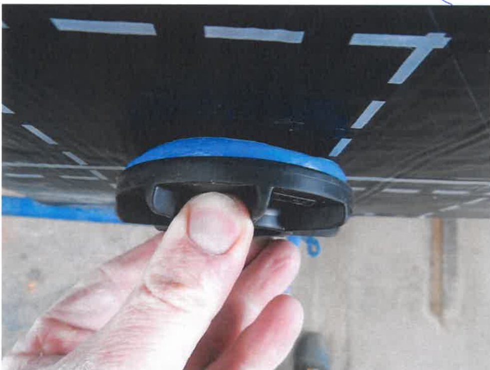
Bild 8 Andrücken des Abdichtelement-Außen
