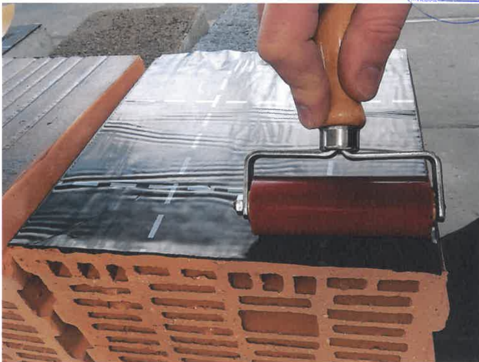
Bild 2 Applikation der Sopro Thene 878 Bitumenabdichtungsbahn
